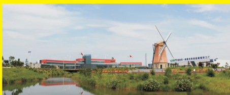
江西电子废弃物循环产业园
